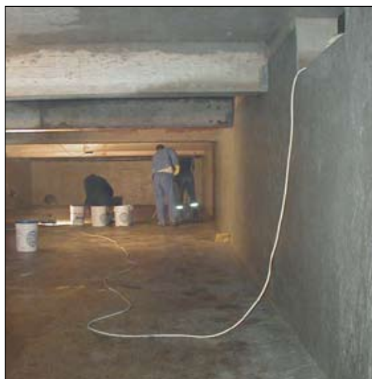
Kad su obrađene sve zidne pukotine, na zidove je utrljan krystol-T1 i prekriven krystolom T2.
