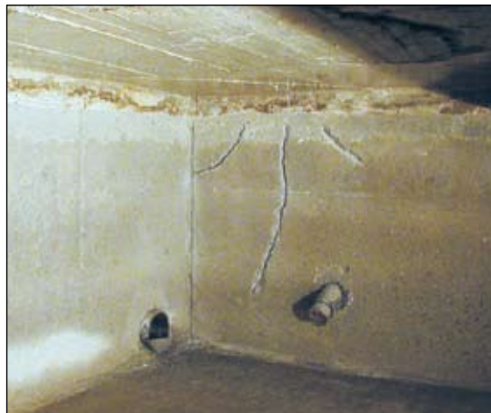
Nakon ponovljenog ispušavanja vode sve su pukotine očišćene i proširene duž otvora.
